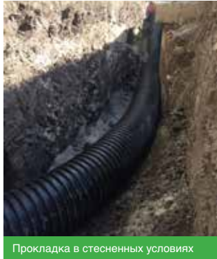
Прокладка в стесненных условиях
