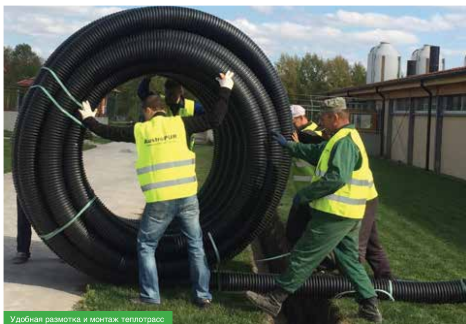
Удобная размотка и монтаж теплотрасс
