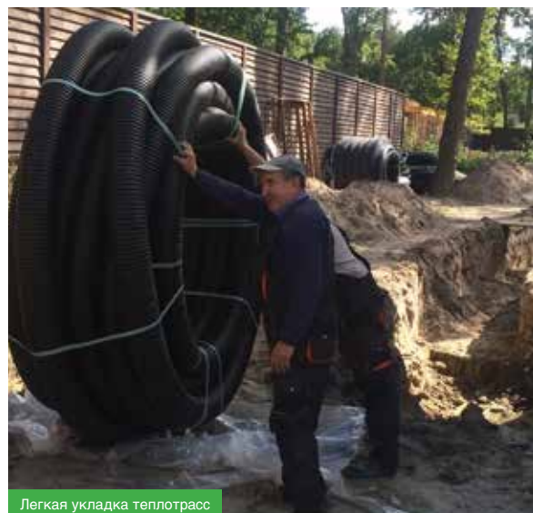
Легкая укладка теплотрасс
